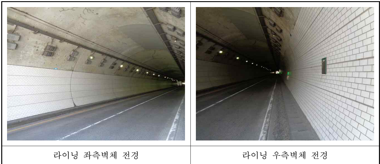
【사진 3.5】 터널 라이닝 측벽부 전경
